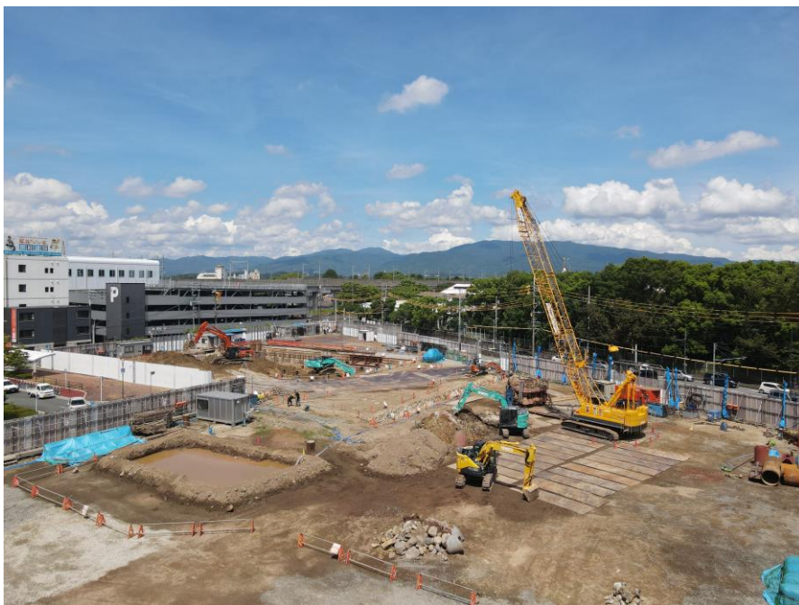
店舗棟 2023.8月撮影
